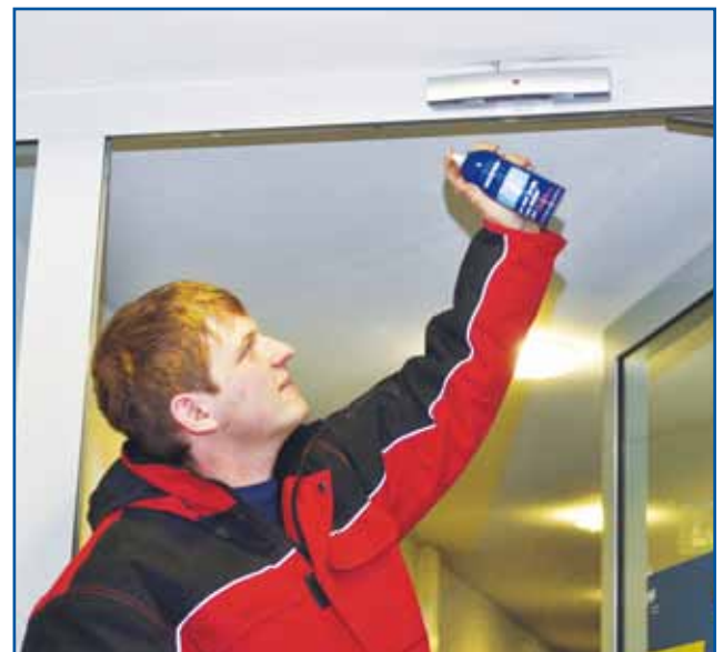
Wartung einer Feststellanlage
