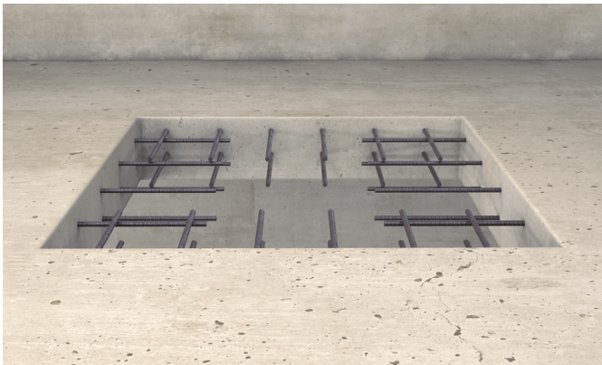
Schließen einer Deckenöffnung
