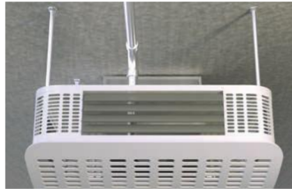
Abgehängte Klimageräte
