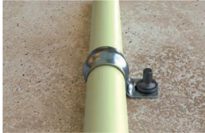
Befestigung von Panzerrohren
