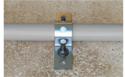
Befestigung von Lochbändern
